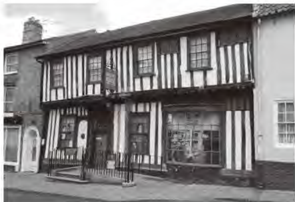
エイシエントハウスミュージアム
